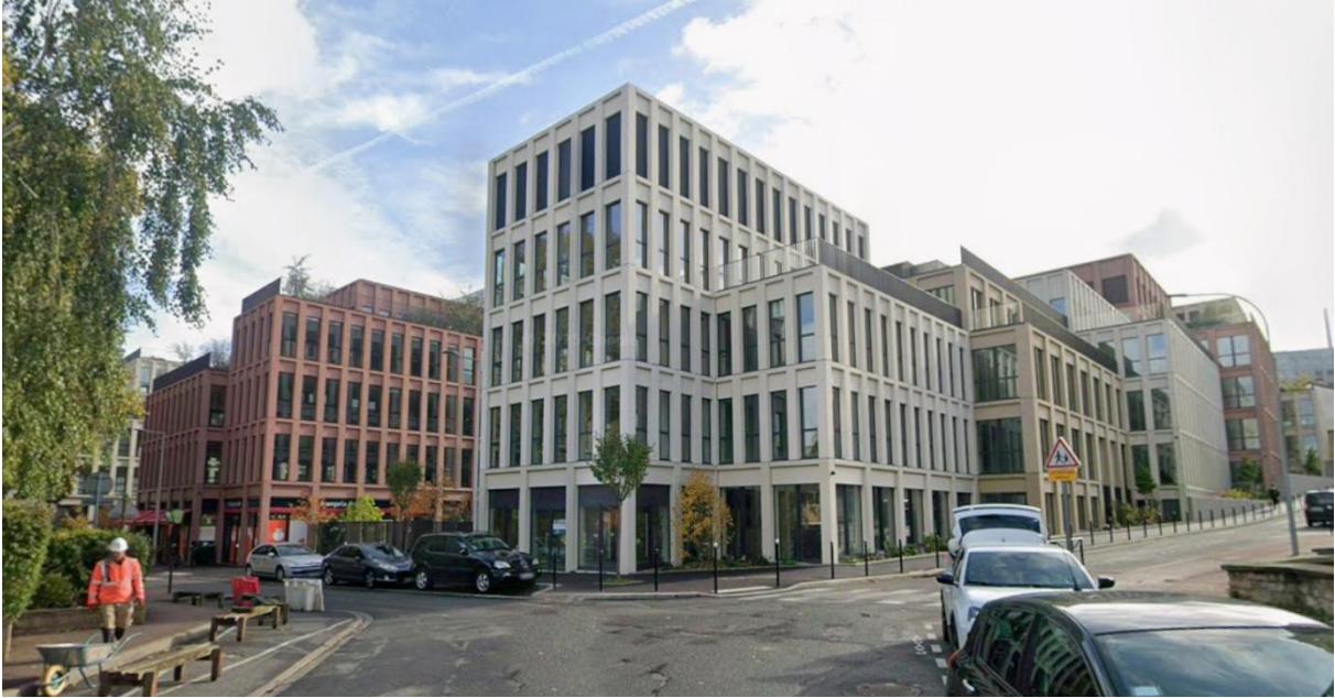
Vue depuis le carrefour rue Allende-rue Benserade (en premier plan le bâtiment A)
