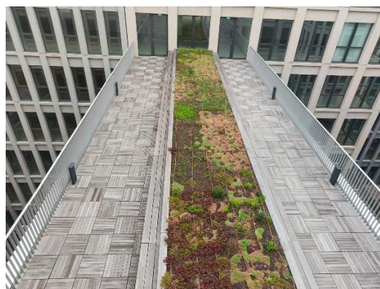
Vue d'une des passerelles
