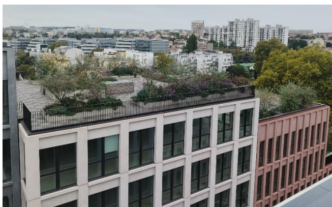
Vue des toitures terrasse du bâtiment A
